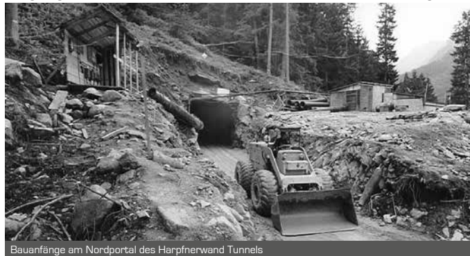
Bauanfänge am Nordportal des Harpfnerwand Tunnels
