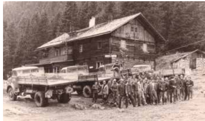
Die ersten Baufahrzeuge bei der alten Dominikushütte
