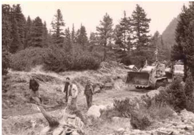
Die Planer der Straße mit den ersten Baumaschinen
